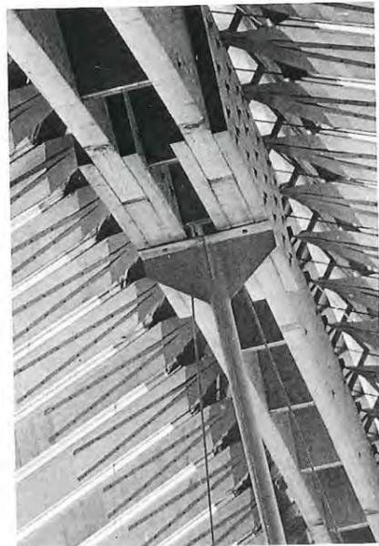
de calcul, de plus en plus précises, permettent d'économiser le volume du bois utilisé en adaptant les sections aux sollicitations engendrées par l'action des charges.
