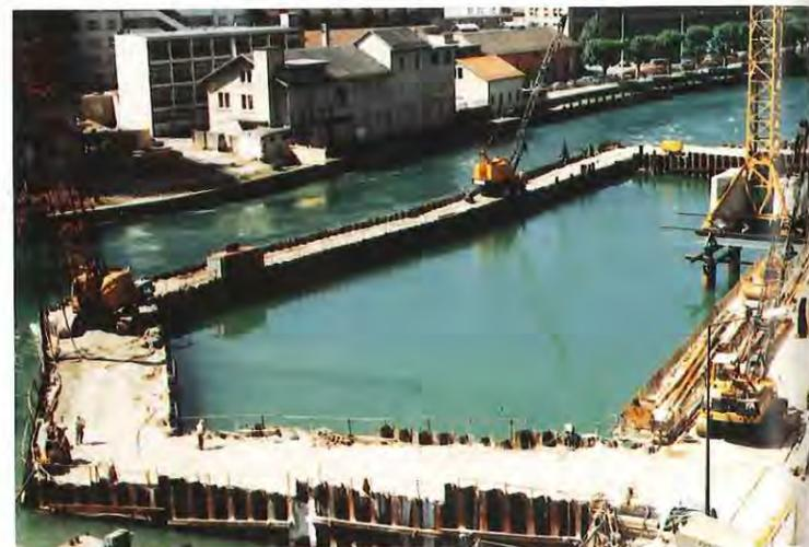
Nouveau barrage de régularisation des eaux du lac Léman et usine hydroélectrique du Seujet. Enceinte batardeau phase I. Etat des travaux en été 1988.
