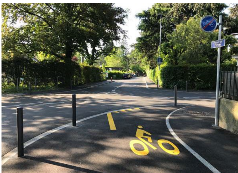
Assainissement du Plateau de Lancy / GE
