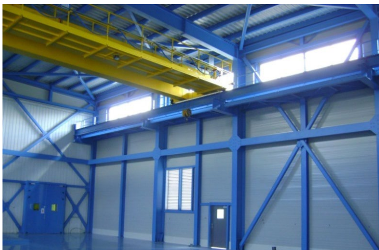
CERN – Bât. Elena, Meyrin Structure métallique - 2014
