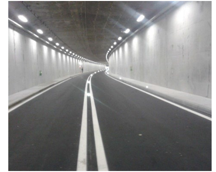
Tranchée couverte de Vésenaz 2011-2014
