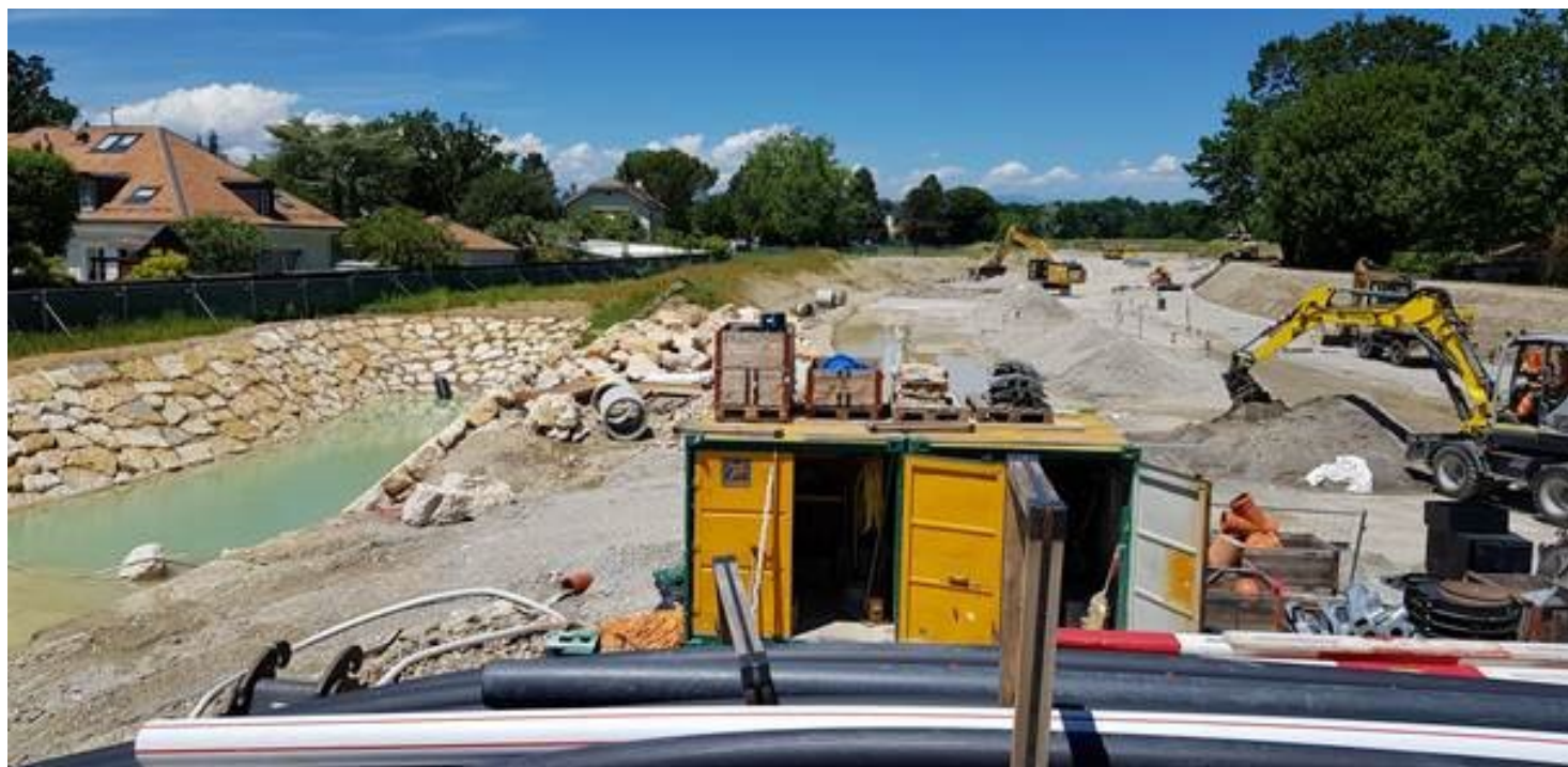
BELLE TERRE - Maillon routier MICA, à Thônex 2018-2020
