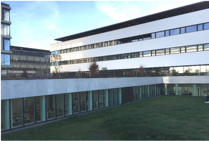
RICHMONT – Campus genevois de Haute Horlogerie, Meyrin 2012 - 2015
