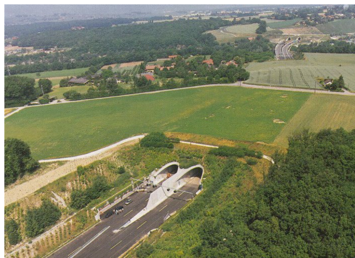
Tranchée couverte de Chèvres Bernex / GE 1988 - 1992
