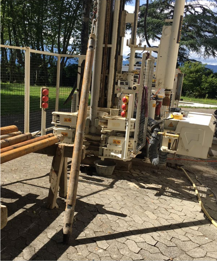
Construction ch. des Marèches Vésenaz 2021
