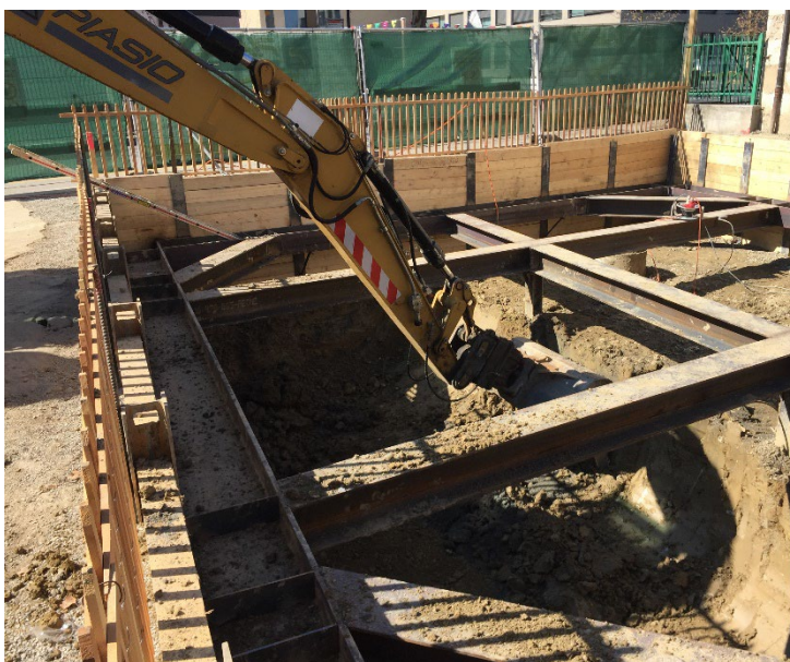
Dépollution station essence et garage de Veyrier 2019
