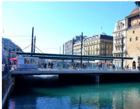
Démolition et reconstruction des Ponts de l'Île - 2008-2011
